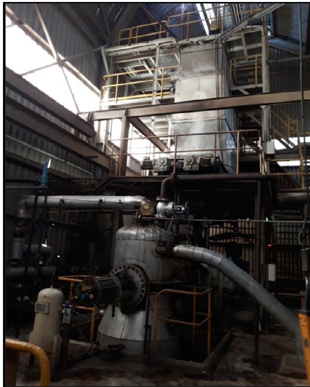
Figura 2-5.: Fotografía silo Vaporizador y cabeza Digestor.
