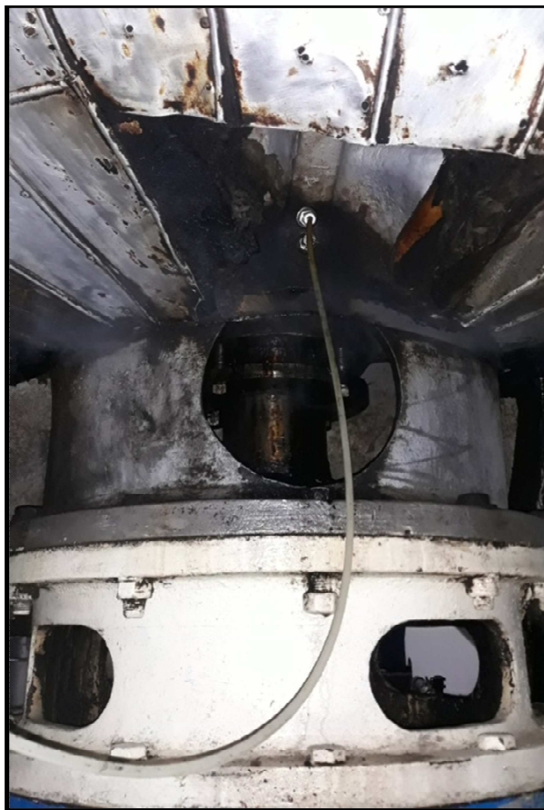
Figura 2-43.: Fotografía punto de lubricación Agitador de fondo del Digestor.
