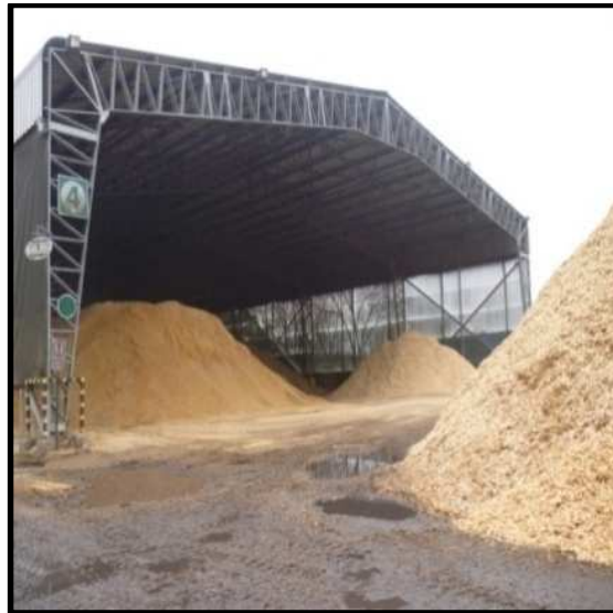
Figura 2-2.: Fotografía canchas de acopio materias primas.
