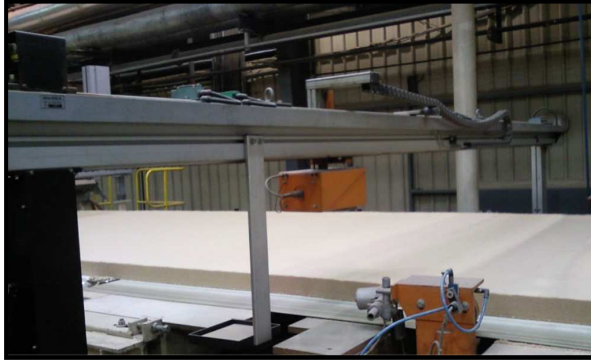
Figura 2-14.: Fotografía Línea de formación.
