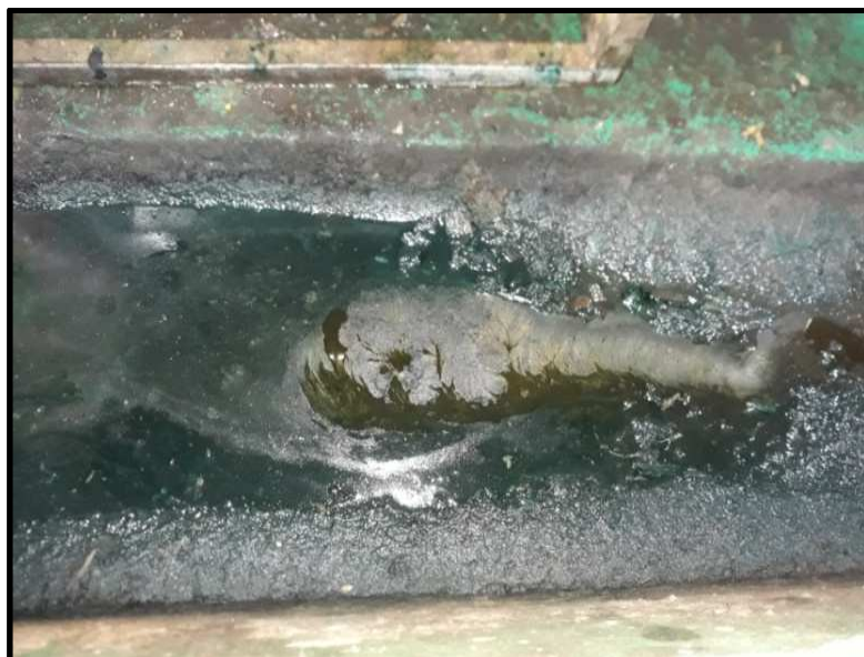
Figura 2-48.: Fotografía trazas de aceite en canaletas.
