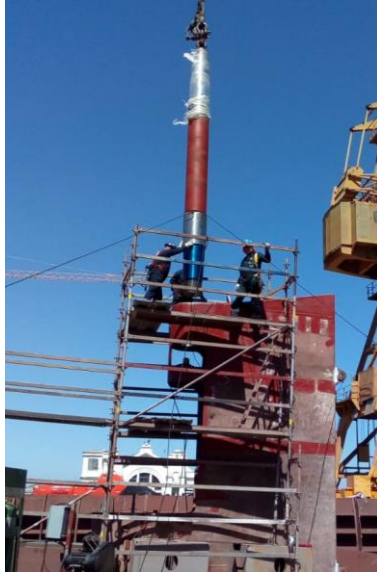
Figura 4-25. Prueba de calado de Mecha en cono superior del timón.
