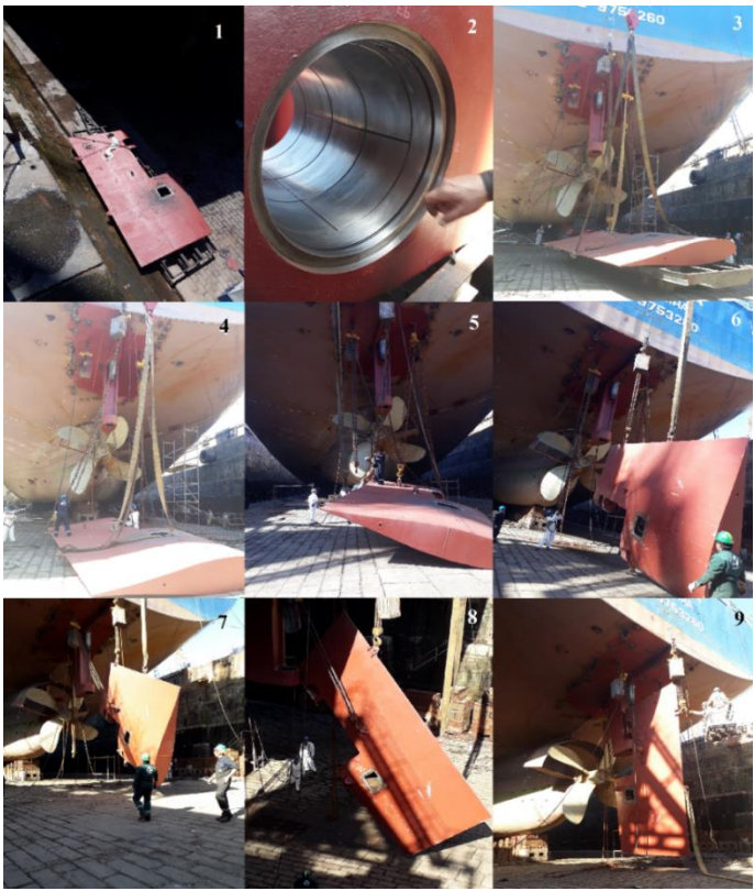
Figura 4-31. Secuencia de montaje del timón en el sistema de gobierno. Fuente: Fotografía adquirida en práctica profesional, 2019.
