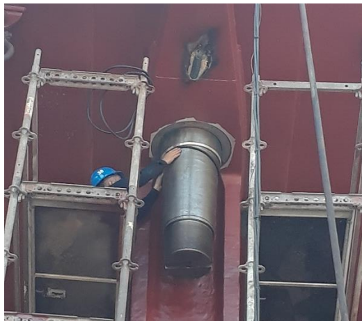
Figura 4-29. Montaje de o’rings en el cono inferior de la Mecha.
