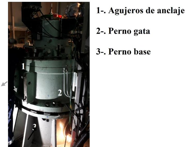
Figura 4-28. Agujeros para el anclaje del servo-motor hidráulico. Fuente: Fotografía adquirida en práctica profesional, 2019.
