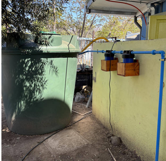
Figura 7: Estanque de almacenamiento y filtros del sistema de reutilización de aguas grises de la escuela. Elaboración propia, 19 de marzo de 2025
