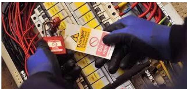
Figura 4.9 Bloqueo de equipo en tablero
