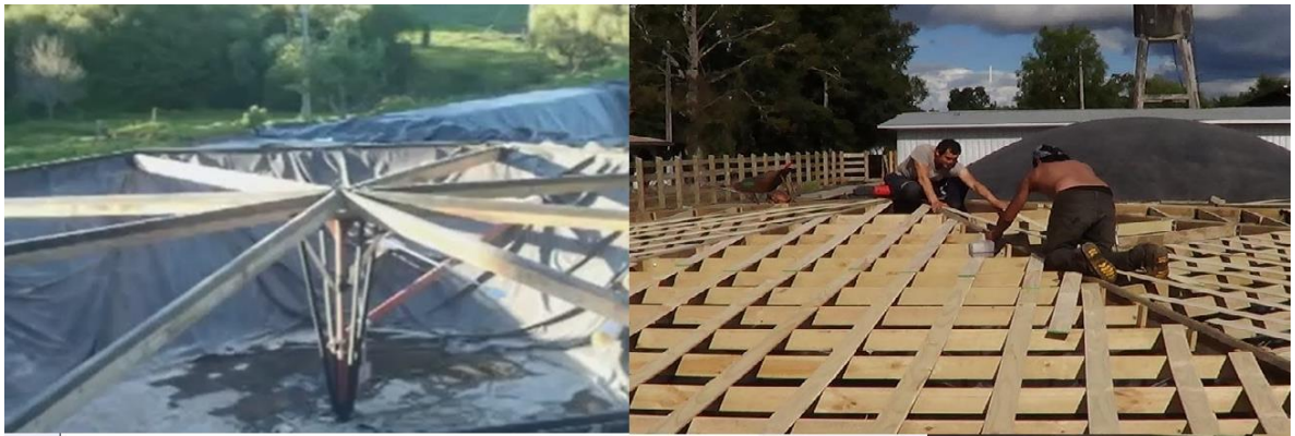
Figura 6.627: Instalación cúpula biodigestor. Fuente: biotecsul
