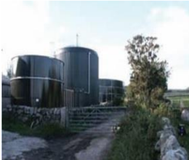
Figura 3.12: Almacenamiento Externo biogás: Fuente: Consorcio lechero
