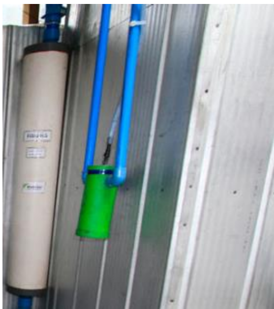
Figura 6.1334: Filtro H 2 S y trampa de agua. Fuente: Biotecsur
