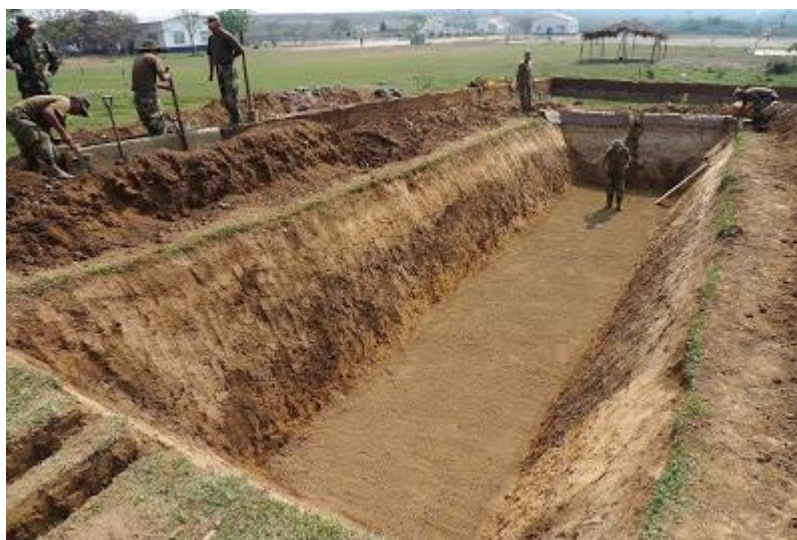
Figura 6.324: Construcción zanja biodigestor. Fuente: Taller biogás
