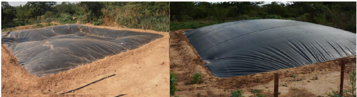
Figura 6.1031: Detalles en juntas del biodigestor. Fuente: Taller biogás
