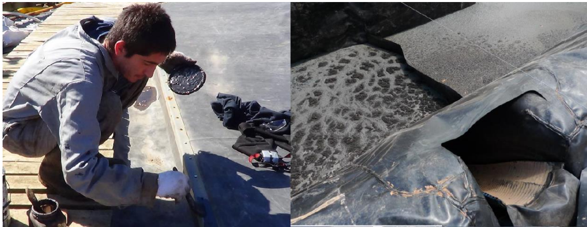
Figura 6.930: Detalles en juntas del biodigestor. Fuente: Taller biogás
