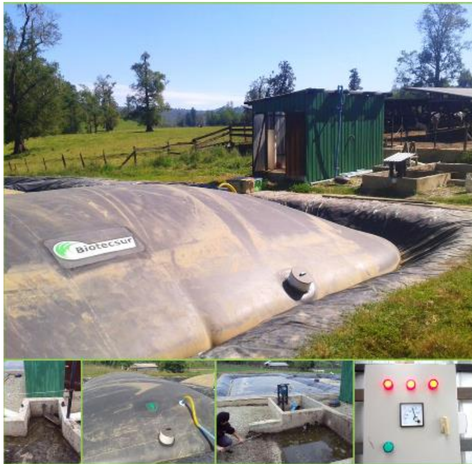
Figura 4.418: Planta biogás Fundo El Maqui, Purrenque. Fuente: Biotecsur
