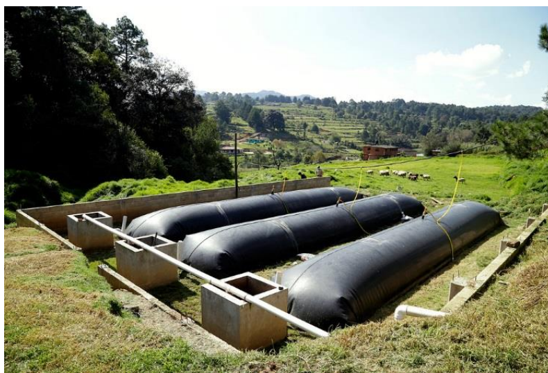
Figura 11.241: Disposición en paralelo biodigestores. Fuente: Dicyt
