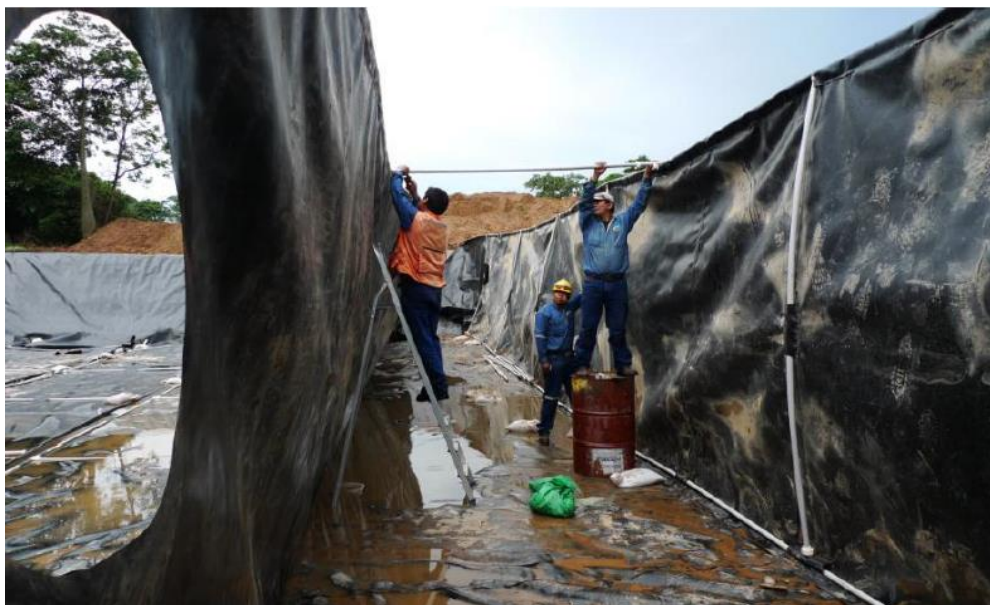
Figura 6.728: Instalación paredes internas biodigestor. Fuente: Taller biogás
