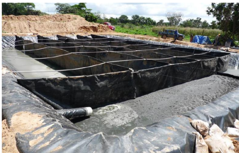
Figura 6.829: Disposición final piscina del biodigestor. Fuente: Taller biogás
