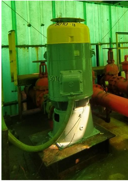
Figura 1-6 Bomba Centrífuga Vertical Multietapas.
