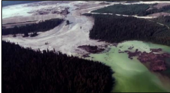
Figura 4-12: La falla de la presa Mount Polley se dio por un terreno inapropiado para su construcción y por el alza de almacenamiento de relave [25].
