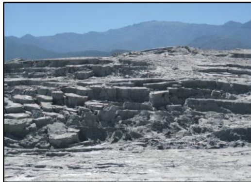
Figura 4-15: Las terrazas escalonadas originadas por el avance de la licuefacción que terminan debilitando la resistencia al corte de los muros [22].
