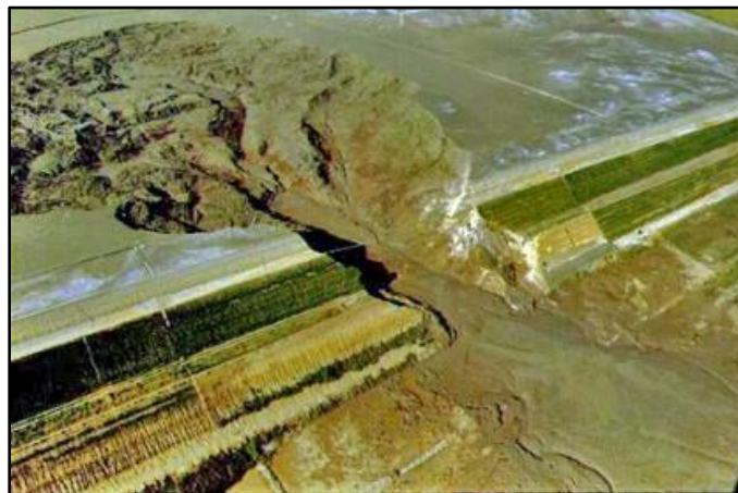
Figura 4-13: Falla de Merriespruit en vista planta. Se liberación 600.000 [m 3 ] de relave, similar a 176 piscinas olímpicas [35].
