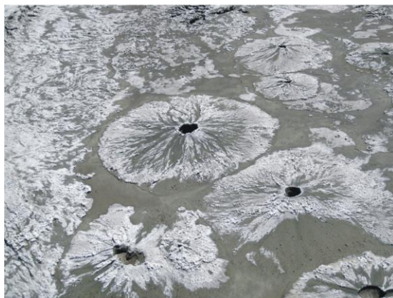
Figura 7-11: La presencia de ebulliciones de arena en el suelo reafirman la posibilidad de una falla de flujo [22].
