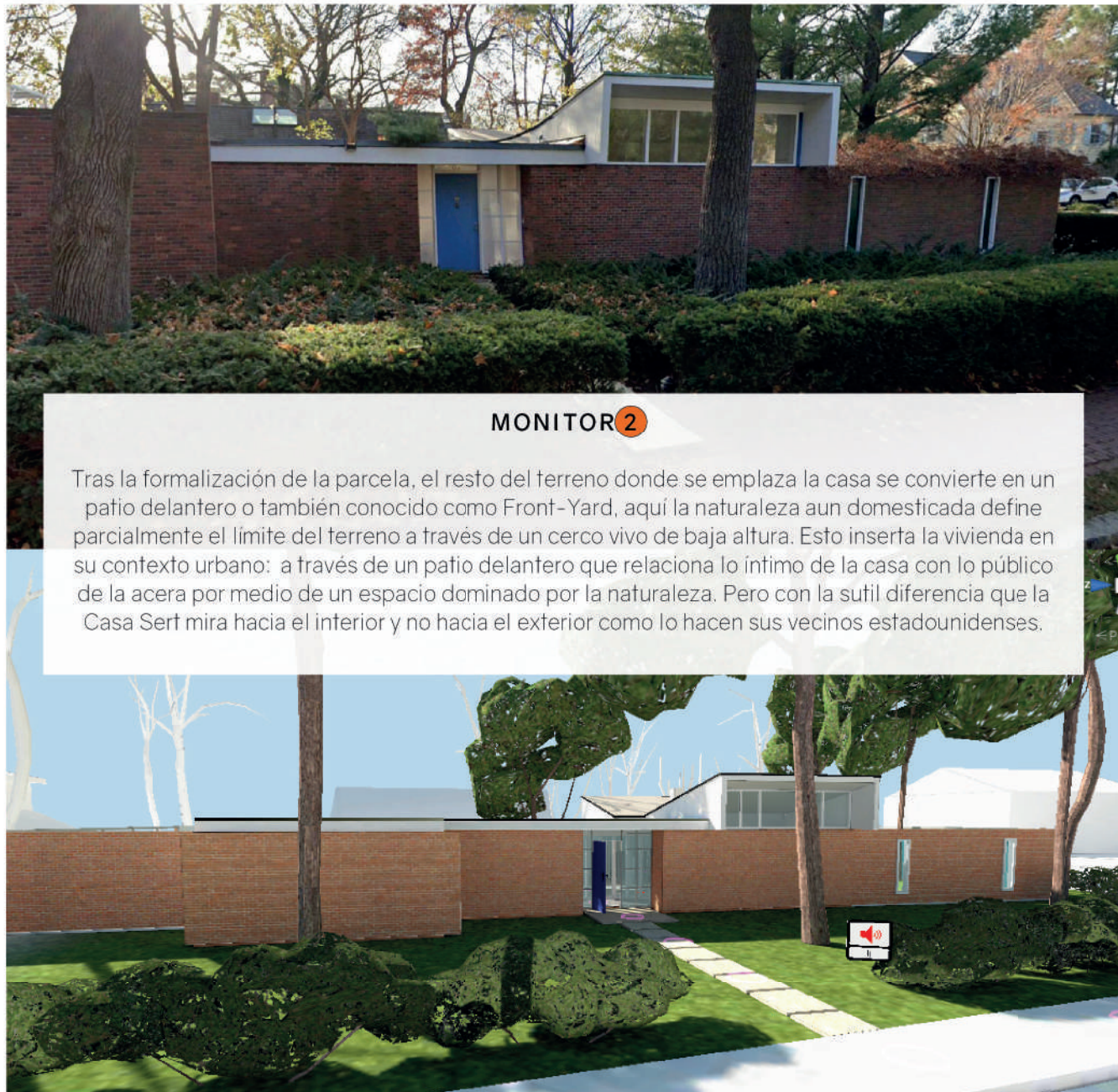
Figura 3.53. Entrada principal Casa Sert. Collage fotografía real versus foto captura representación virtual caso de estudio. (Fuente: Elaboración Propia).
