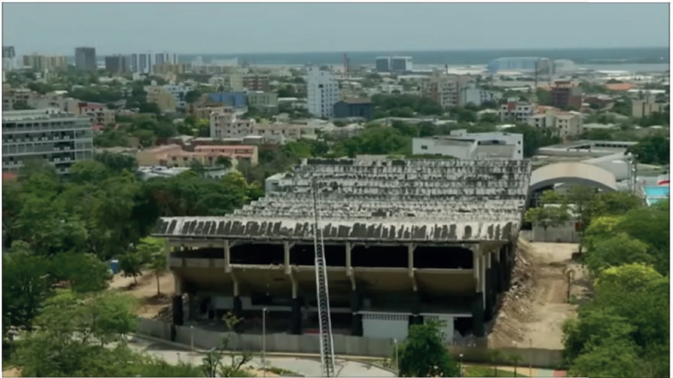
Figura 2.11. Foto captura video de la demolición del Coliseo Humberto Perea. (Fuente: Elaboración Propia).
