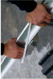
Sujeción del perfil TS
