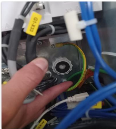
Figura 3 - 19 Filtro unidad de control KR C4 Fuente: Elaboración propia
