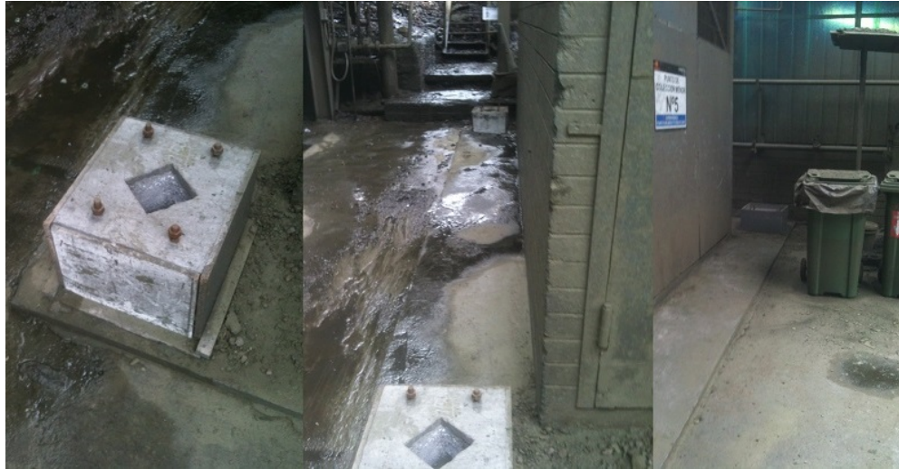
Figura 3.3: Fundaciones de sala de controladores
