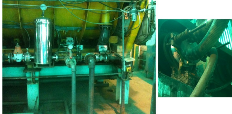
Figura 1.15: Sistema de retrolavado
