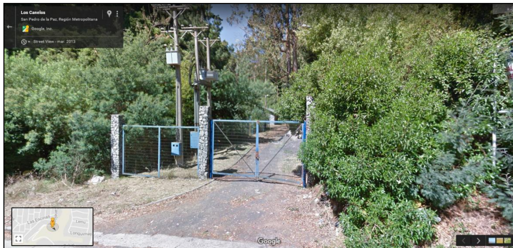
Figura 3-1 Acceso Planta Elevadora de Agua Potable Andalué.
