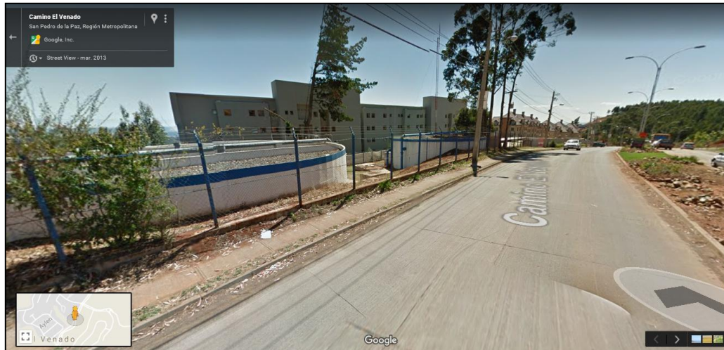
Figura 3-2 Estanque Andalué ubicado en la subida El Venado.
