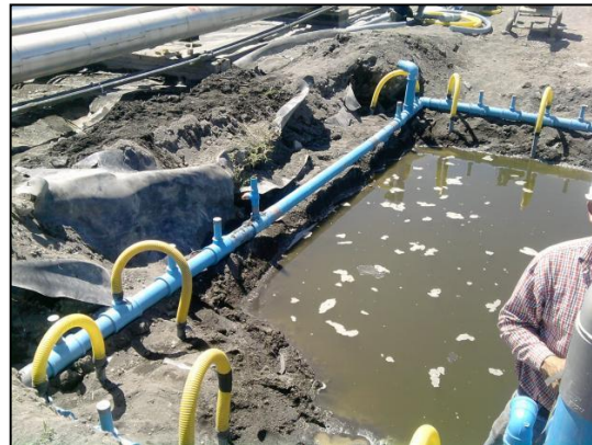
Figura 1-6 Malla de punteras para agotar napa.
