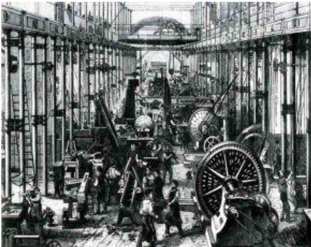
Figura 1 1:Obreros trabajando en un edificio industrial.
