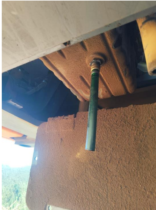
Figura 1 23: instalación de válvula ecológica.
