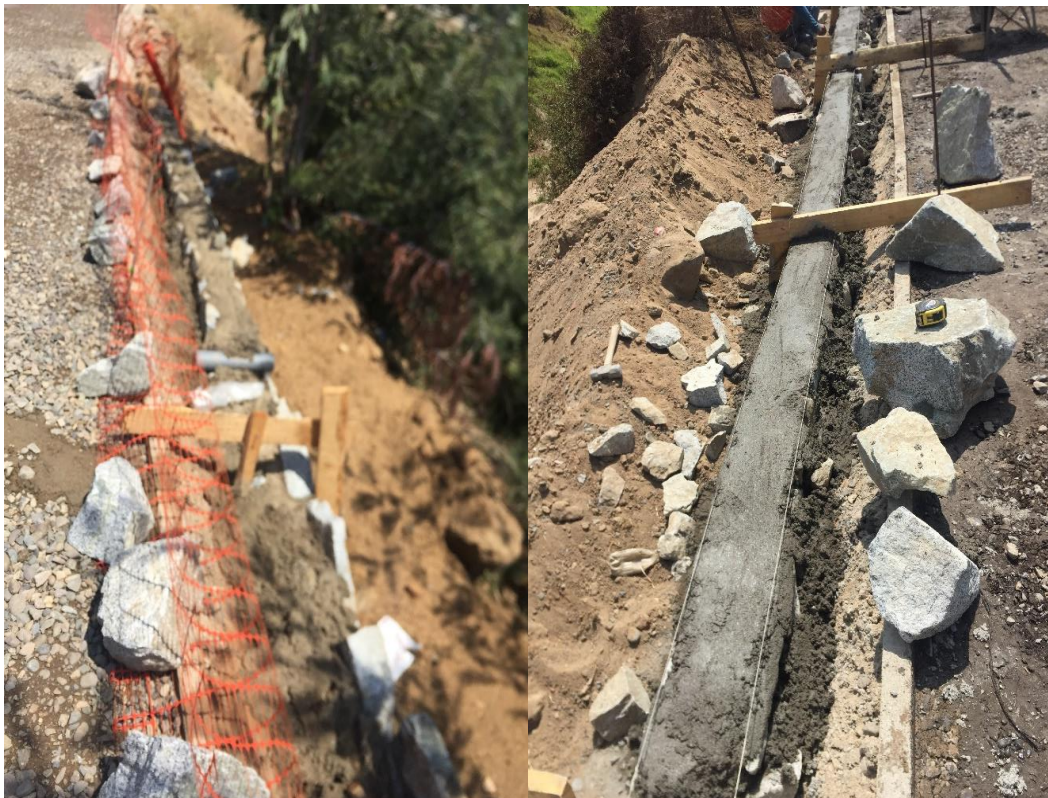
Figura 2-1. Muros de mampostería al borde del canal
