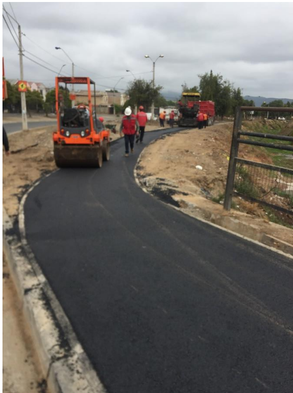
Figura 2-9. Instalación de asfalto
