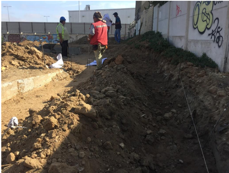
Figura 2-16. Replanteo previo a la construcción de ciclovías
