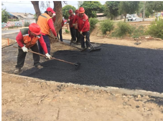
Figura 2-8. Instalación manual de asfalto
