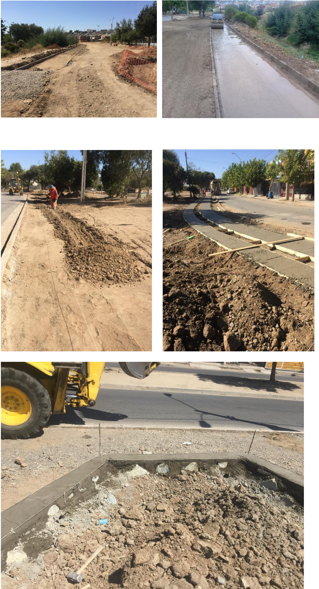
Figura 2-19. Registro de trabajos realizados en obra
