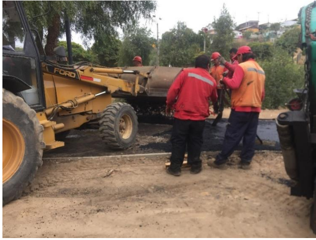
Figura 2-6. Proceso de instalación de asfalto
