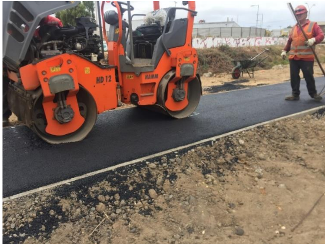
Figura 2-7. Compactación del asfalto
