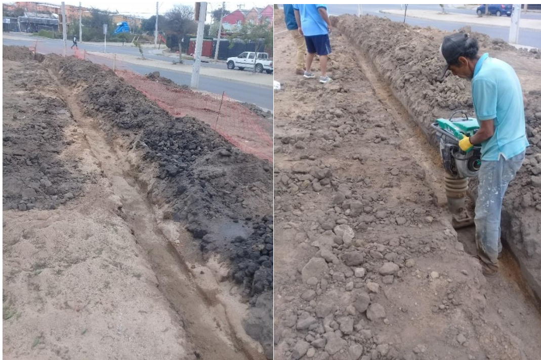
Figura 2-18. Instalación de Riego
