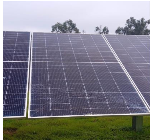
Fuente: Registro fotográfico interno de inspección en terreno
