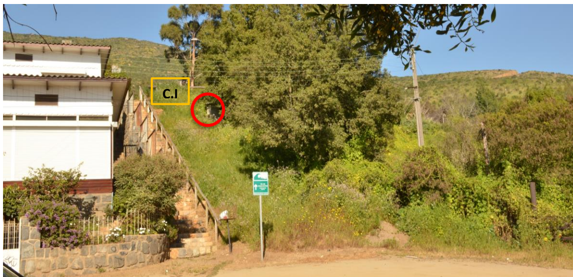
Figura 38. Vista terreno cercano a la orilla en la zona Oeste del sector 1.
