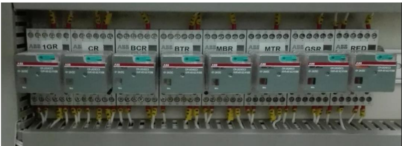
Ilustración 1-8: Relés salidas el easy gen 3200.
