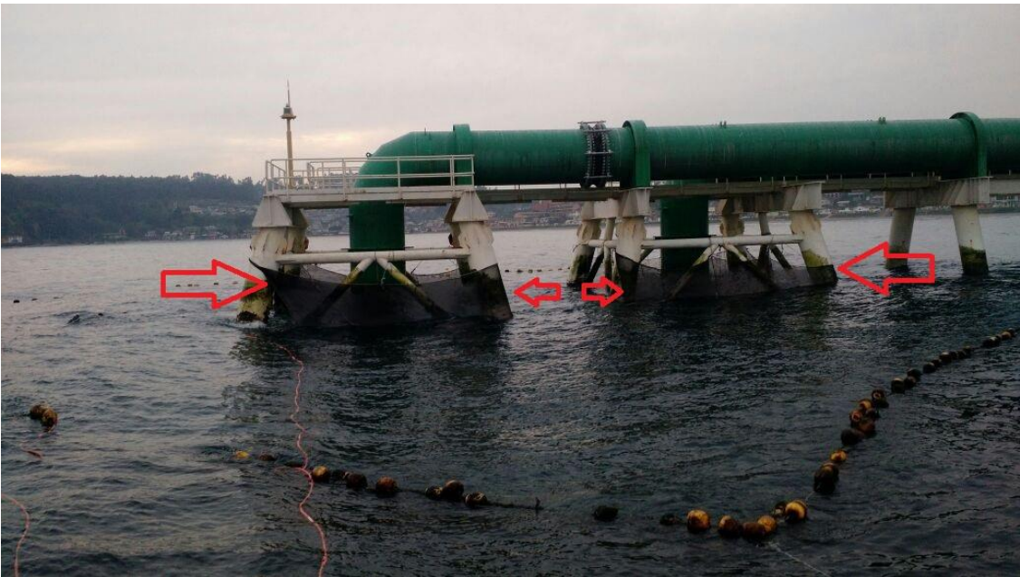
Fuente: Archivo personal. 2015, fotografía tomada en faenas de limpieza de mallas
