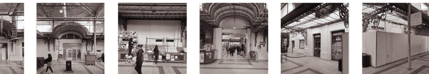
Figura 57. Levantamieto fotográfico fachada edificio Oriente. Elaboración propia en base a práctica en metro de Santiago (2024).
