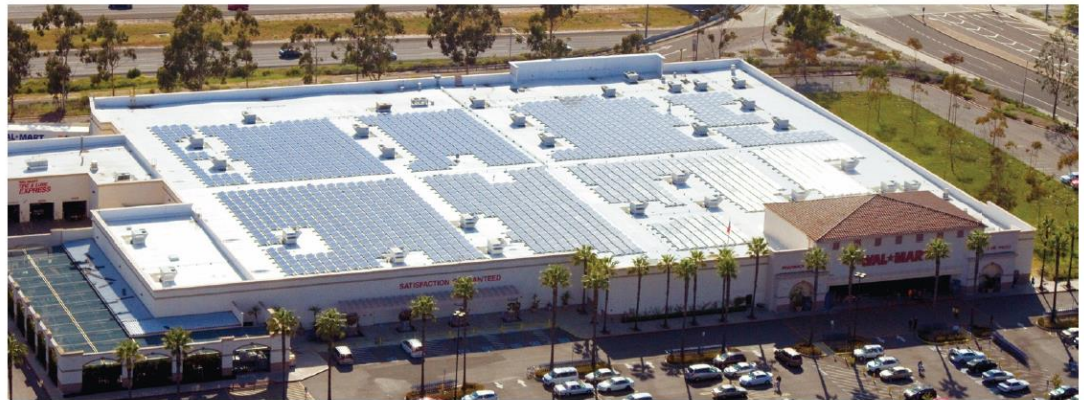
Figura 1.2. Proyecto fotovoltaico, Walmart Foothill Ranch, California. Potencia instalada 412 kWp. Fuente: Solarcity
