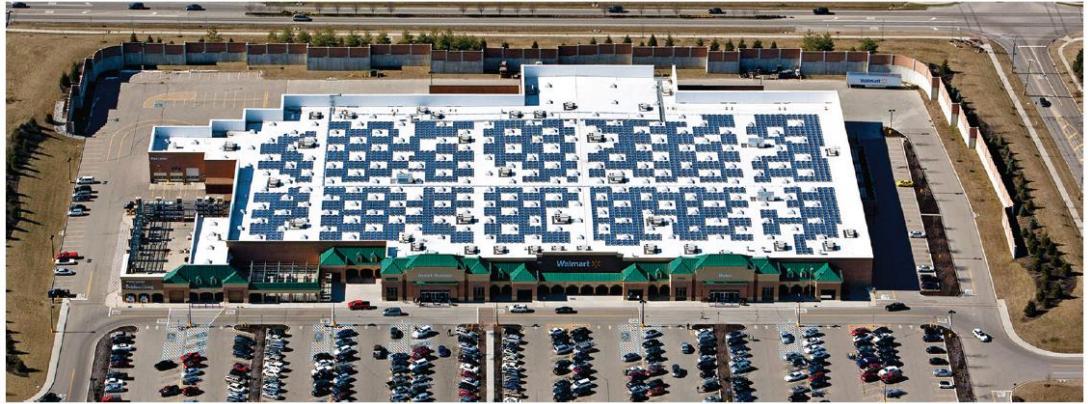
Figura 1.1. Proyecto Fotovoltaico, Walmart Cincinnati, Ohio. Potencia Instalada 585 kWp. Fuente: Solarcity
