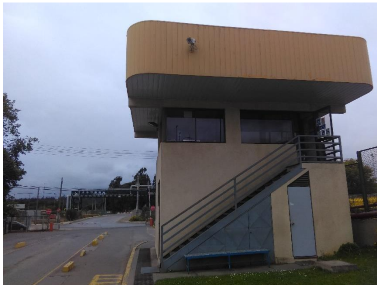
Figura 5.4 Romana de pesaje y sala de supervisión, Fotografía captada 19 noviembre 2020.
