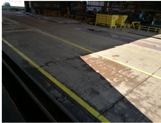
Figura 4.12: Zona de acopio de material. Fuente: Elaboración propia.
