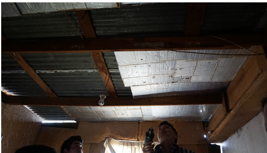
Figura 5.8: Forrado de cielo en vivienda social de Viña del Mar.
