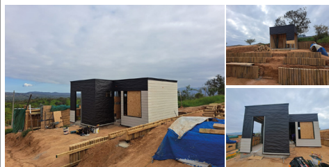
Figura 04: Registro fotográfico avance obra Peñablanca
