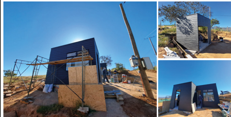
Figura 03: Registro fotográfico avance obra Peñablanca
