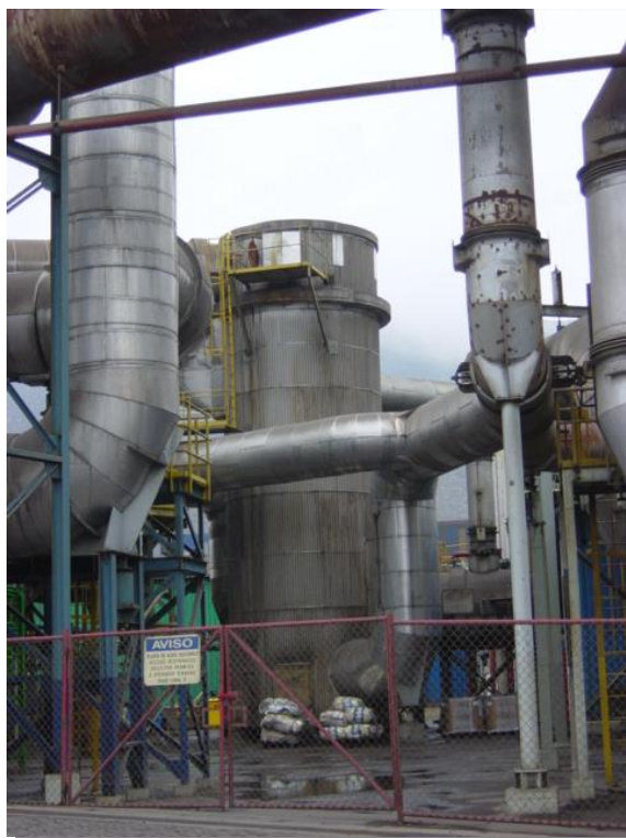
Figura 2-1: Etapa de Conversión de \text{SO}_2 a \text{SO}_3 en la planta de ácidos Chagres.
