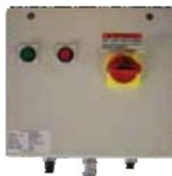
Figura 4.15 Caja de Control Fuente: Manual Clyde Industries
