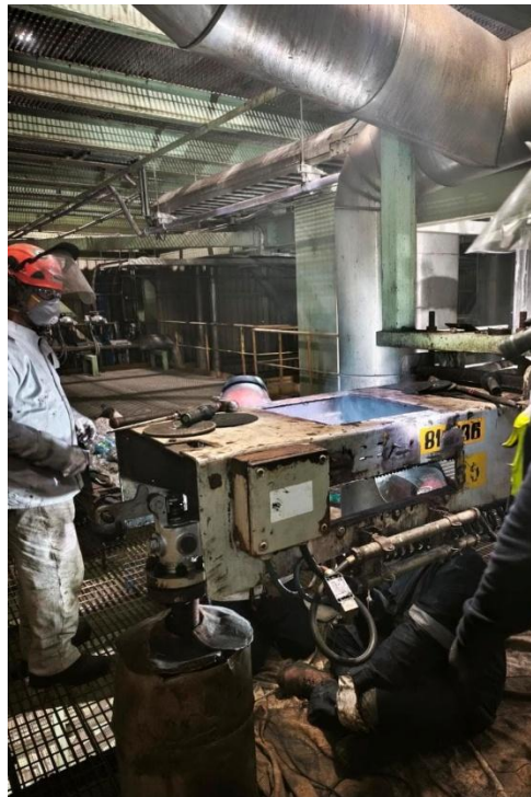
Figura 4.4 Mantenimiento a Deshollinadores Fuente: Siming LTDA
