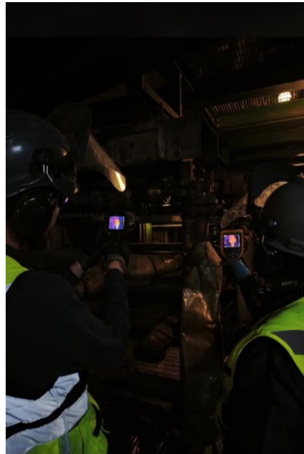
Figura 5.2 Termografía en Terreno Fuente: Siming LTDA
