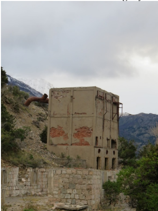
Foto 28: Cimientos de las bodegas y estructura de planta
