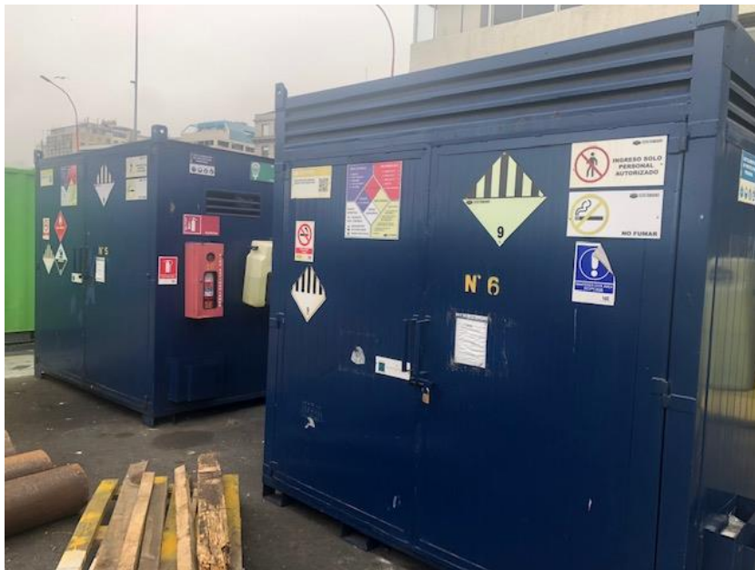
Figura 9. Almacenamiento de sustancias peligrosas. Fuente: Registro fotográfico empresa.
