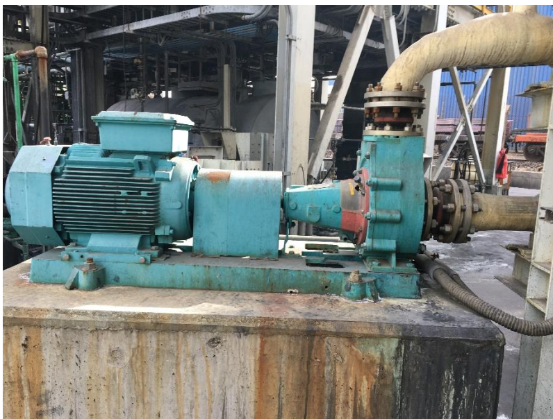
Ilustración E.3: Bomba flushing de hornos de refinación.
