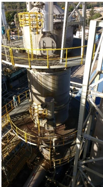
Ilustración 2.6: Precipitador electrostático húmedo de hornos de refinación (Wesp).
