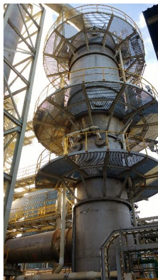
Ilustración E.1: Precipitador electrostático húmedo de hornos de refinación.
