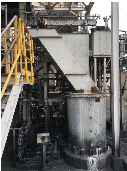
Ilustración F.1: Filtro separador lamella de hornos de limpieza de escoria.
