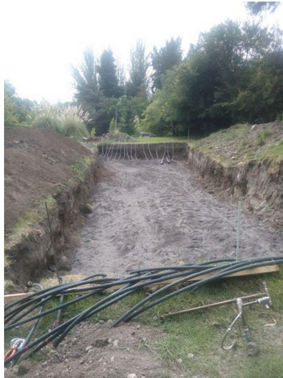
Figura 4.5 piping de la zona de colector horizontal
