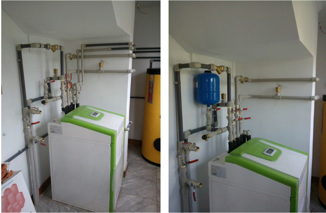
Figura 4.3 instalación de bomba de calor
