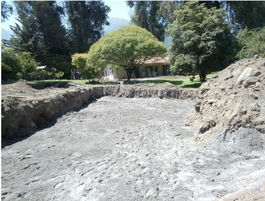
Figura 4.4 preparación del terreno para la instalación geotérmica.
