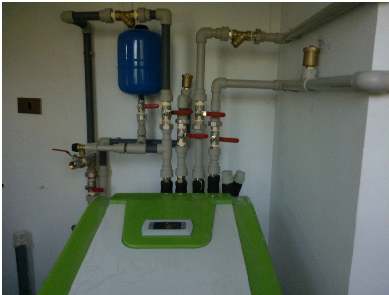
Figura 4.4 , instalación del piping de la bomba de calor
