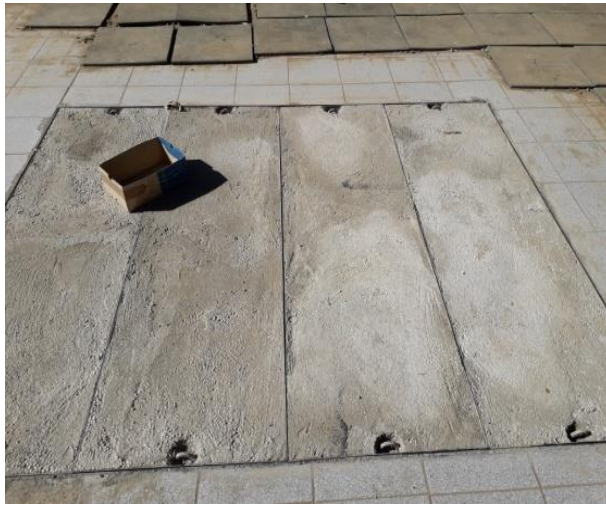
Figura 2- 24tapa desengrasadora terminada
