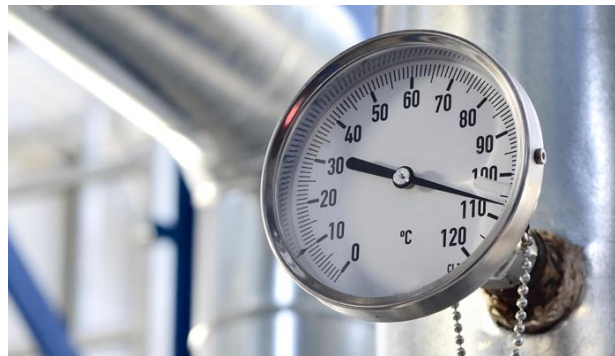
Ilustración 3- 17: Termómetro instalado en equipo de vapor.
