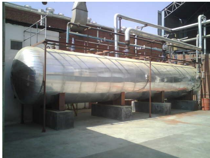
Ilustración 3- 3: Acumulador de vapor horizontal de presión variable.
