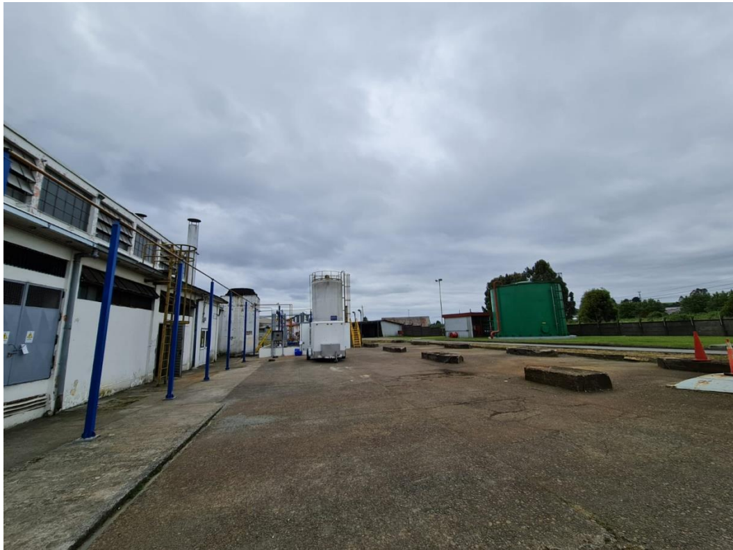
Ilustración 3- 29: Patio actual de la sala de calderas fábrica Nestlé Llanquihue.
