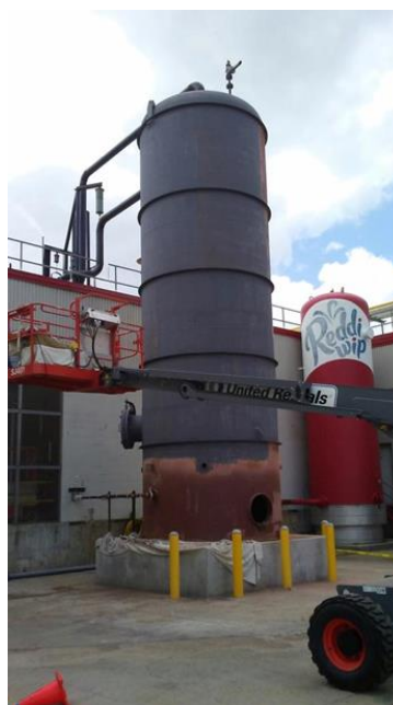
Ilustración 3- 4: Acumulador de vapor vertical de presión variable.
