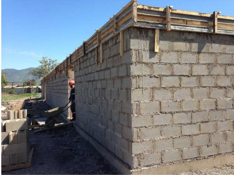
**Imagen N°2.- Albañilería armada de bloque, Estadio Pueblo Nuevo, La Calera**
