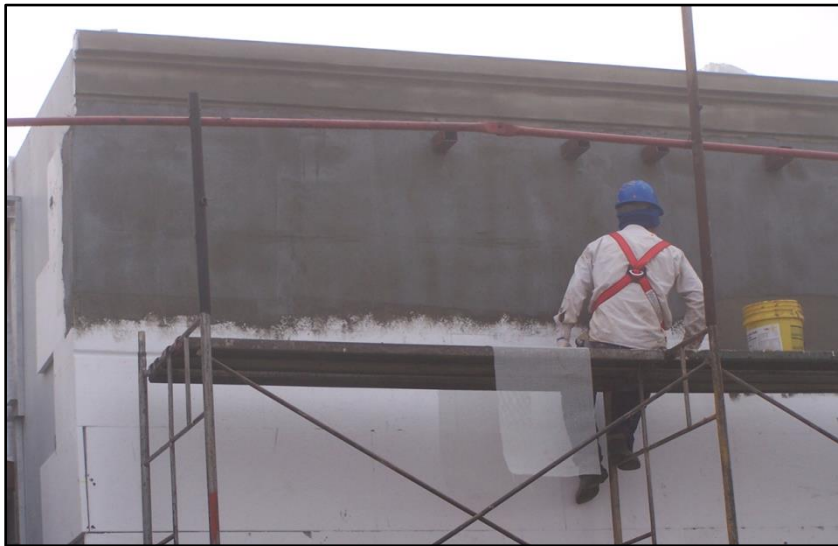
Ilustración 25. Ejecución del sistema de aislación exterior.
