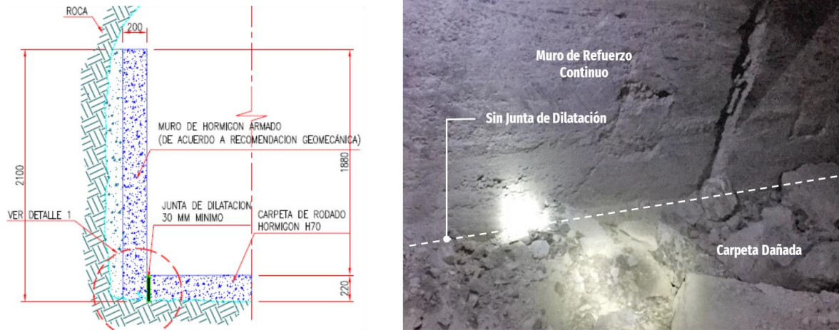
Figura 3.41. Daño por ausencia de juntas de dilatación en Nivel de producción. Ref: Muñoz R. (2024).
