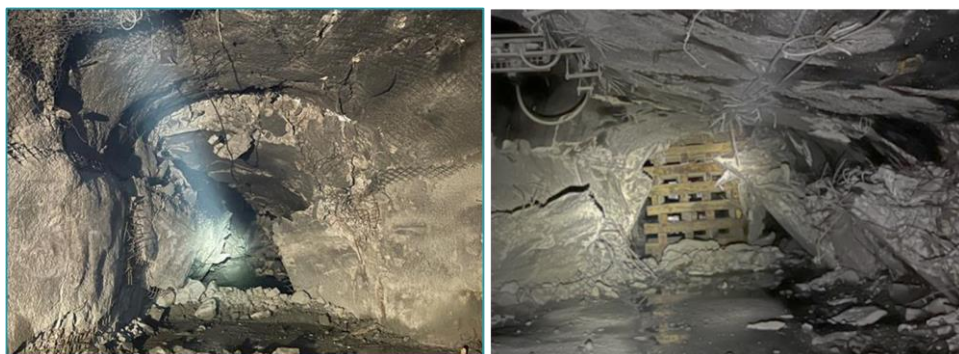
Figura 2.22. Colapsos reales dentro de la mina. Ref: Muñoz R. (2020).
