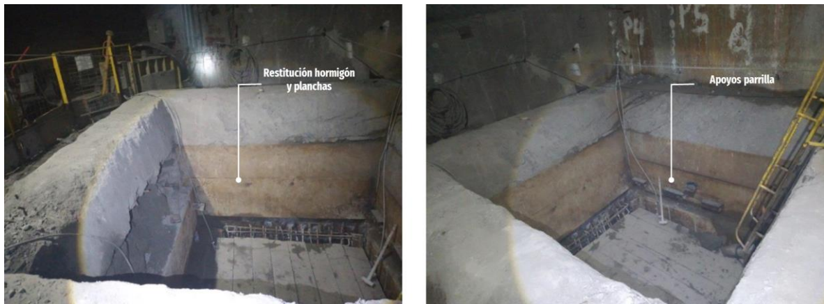
Figura 3.51. Rediseño interno e implementación de apoyos para parrillas. Ref: Gómez J. (2024).
