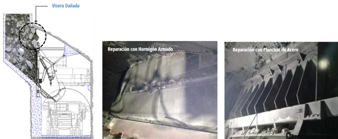
Figura 3.69. Reparación de viseras dañadas con HA o planchas de acero. Ref: Martínez A. & Muñoz R. (2024).
