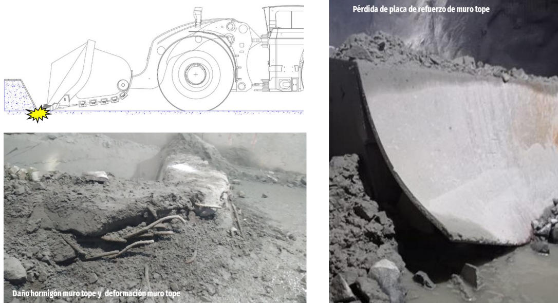
Figura 3.49. Pérdida de blindaje y posterior daño en hormigón de muro tope. Ref: Muñoz R. (2024).
