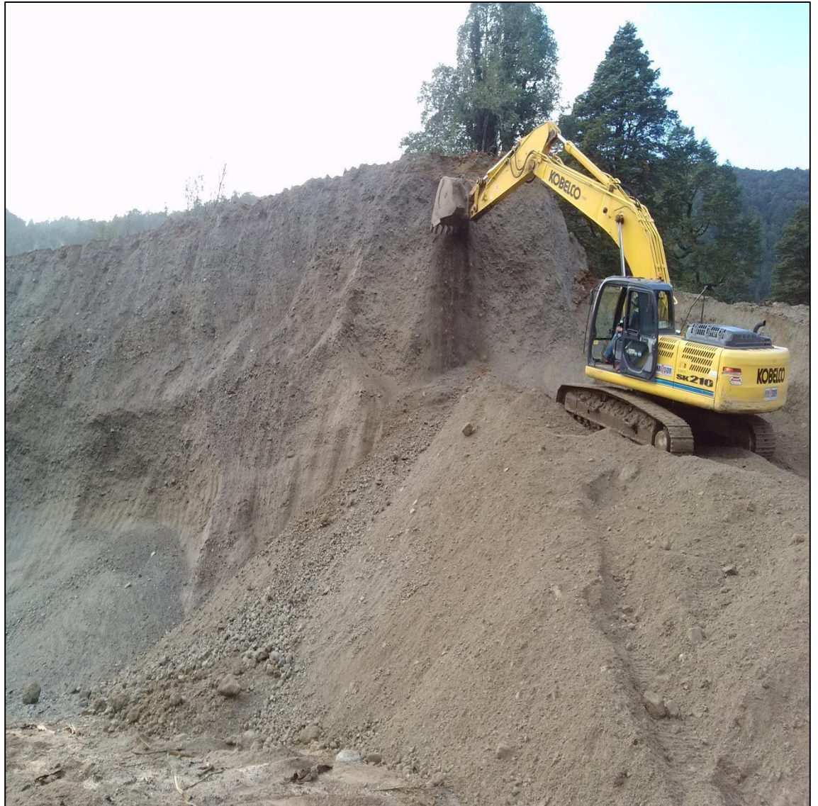
Figura 2.6. Fotografía Empréstito en pozo, Obra "Mejoramiento Camino Longitudinal Austral Ruta 7, Sector Limite Regional-La junta". XI Región de Aysén.
