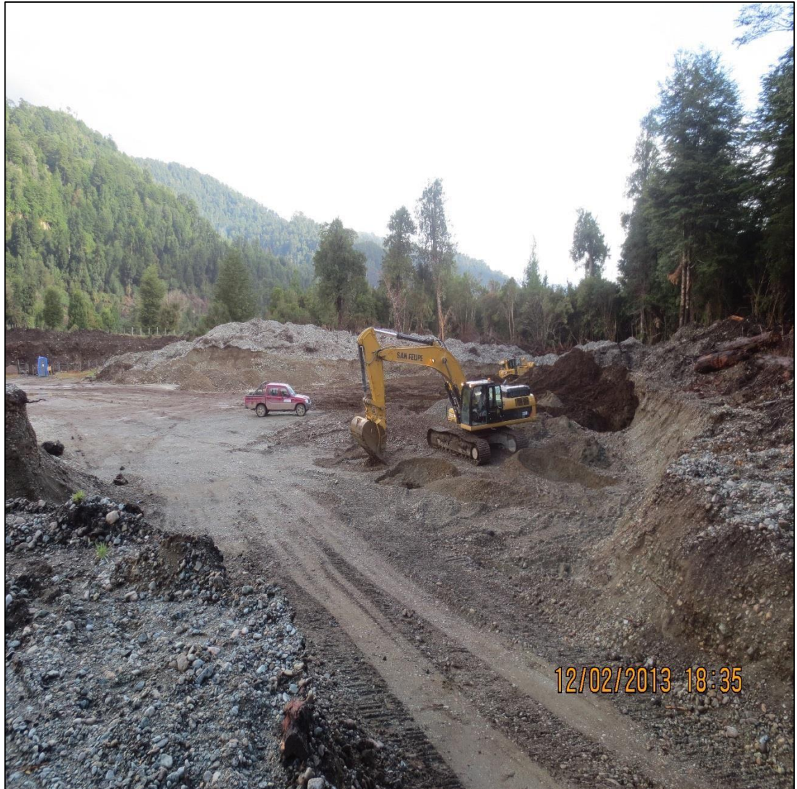
Figura 2.7. Fotografía Empréstito en pozo Obra "Mejoramiento Camino Longitudinal Austral Ruta 7, Sector Limite Regional-La junta". XI Región de Aysén.
