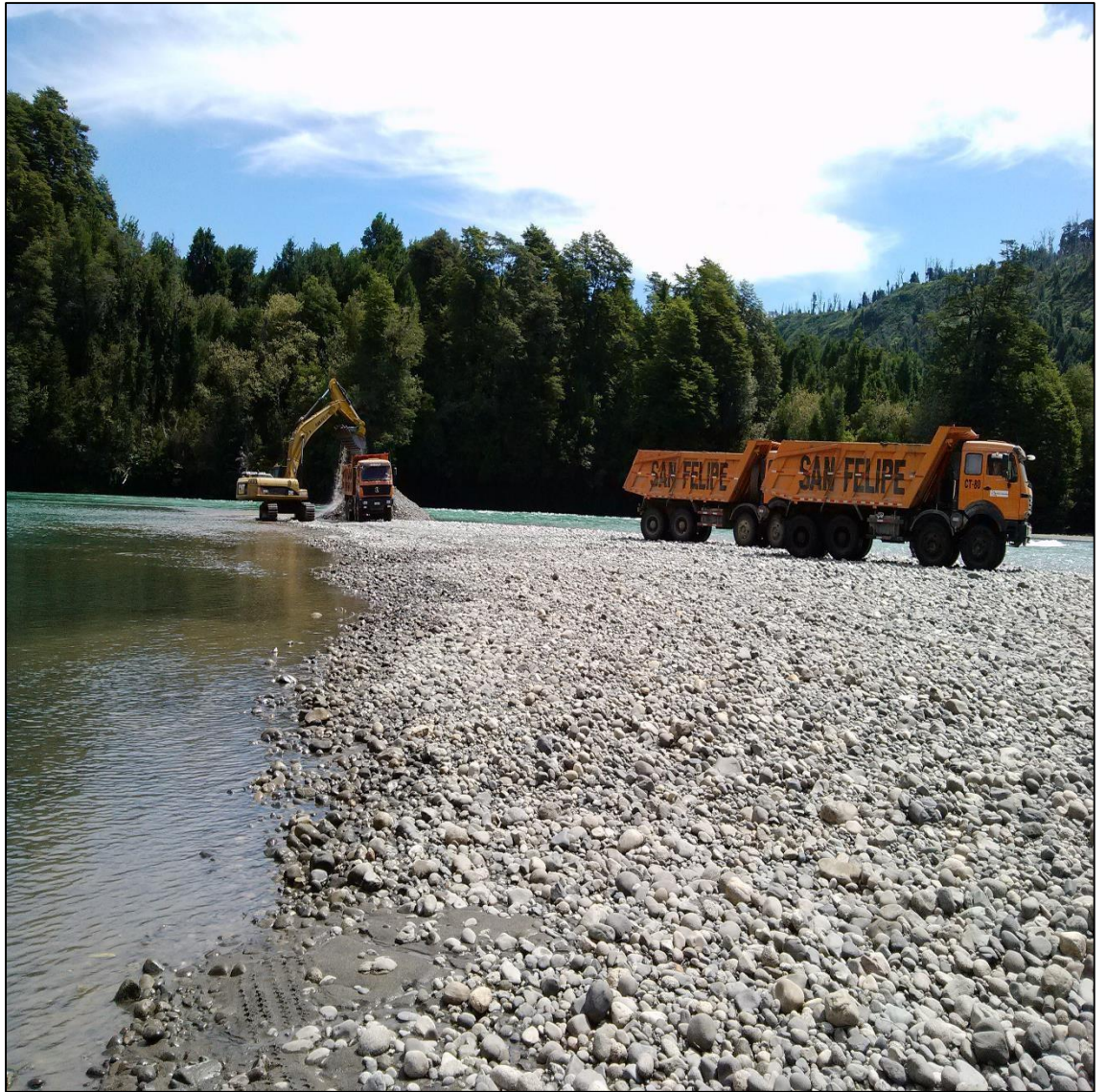
Figura 2.4. Fotografía empréstito en cauce natural Obra "Mejoramiento Camino Longitudinal Austral Ruta 7, Sector Limite Regional-La junta". XI Región de Aysén.
