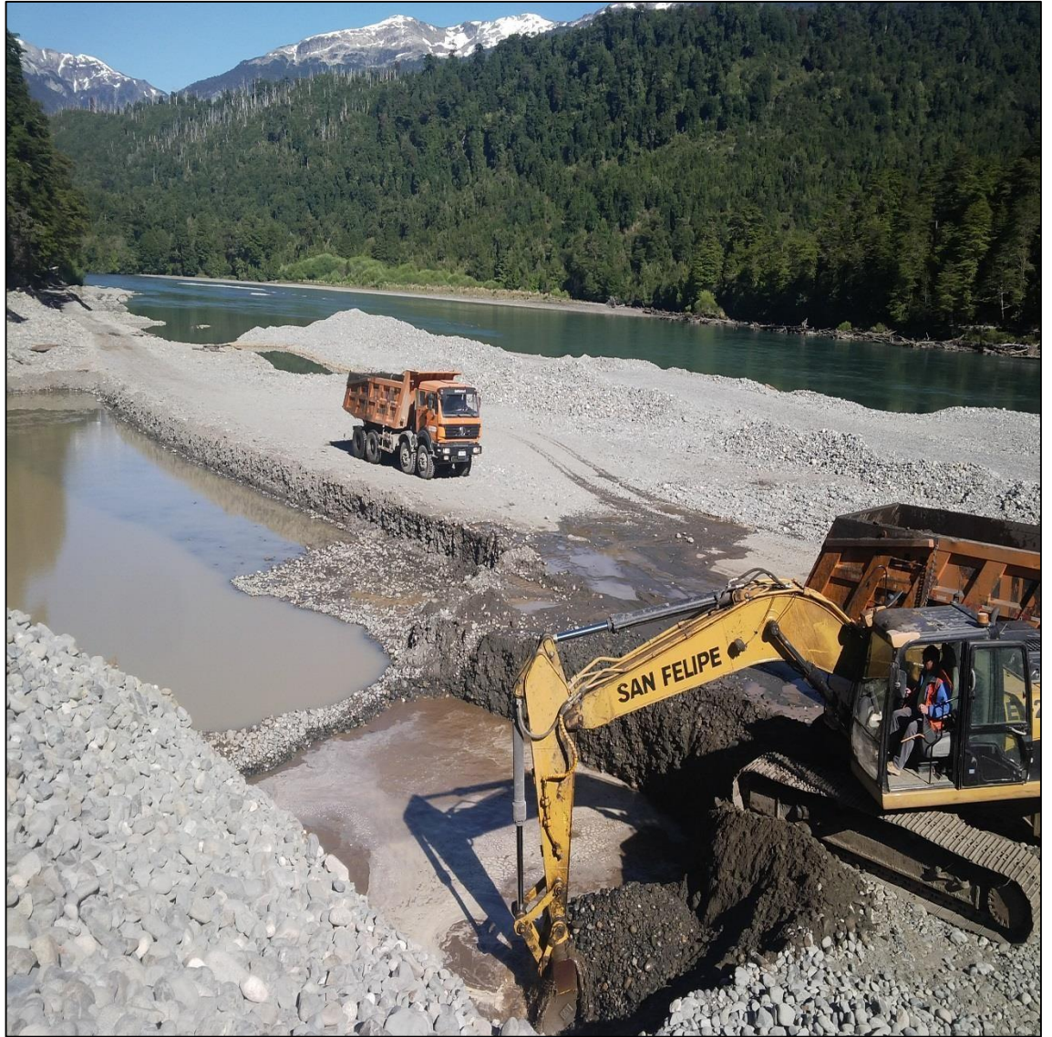
Figura 2.5. Fotografía empréstito en cauce natural Obra “Mejoramiento Camino Longitudinal Austral Ruta 7, Sector Limite Regional-La junta”. XI Región de Aysén.
