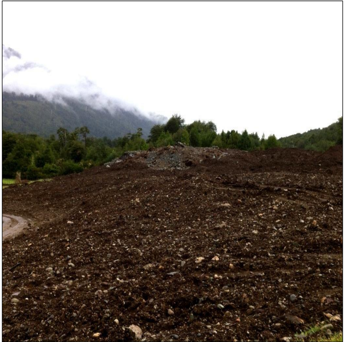
Figura 2.3. Fotografía Botadero Obra "Mejoramiento Camino Longitudinal Austral Ruta 7, Sector Limite Regional-La junta". XI Región de Aysén.
