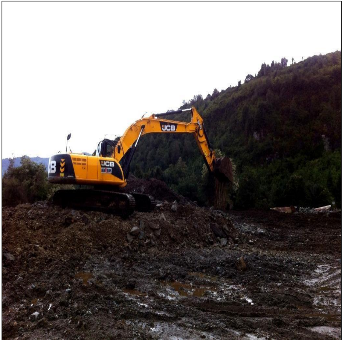
Figura 2.2. Fotografía Botadero Obra "Mejoramiento Camino Longitudinal Austral Ruta 7, Sector Limite Regional-La junta". XI Región de Aysén.
