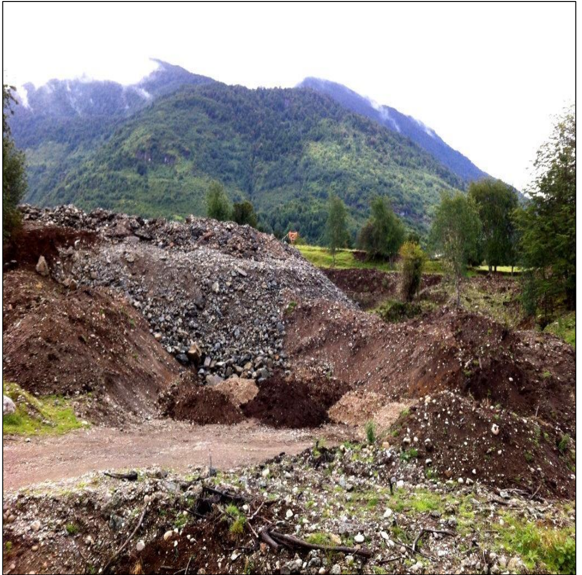
Figura 2.1. Fotografía Botadero Obra "Mejoramiento Camino Longitudinal Austral Ruta 7, Sector Limite Regional-La junta". XI Región de Aysén.
