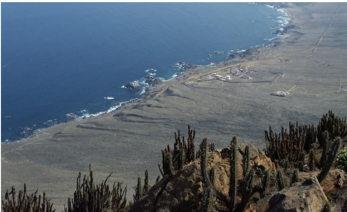
Vista desde Paposo hacia el Poniente donde se observa las instalaciones de la Termoeléctrica Taltal. Fuente: Autoría propia.
