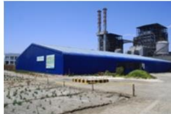
Instalaciones en Mejillones de piscicultura de Cobia
