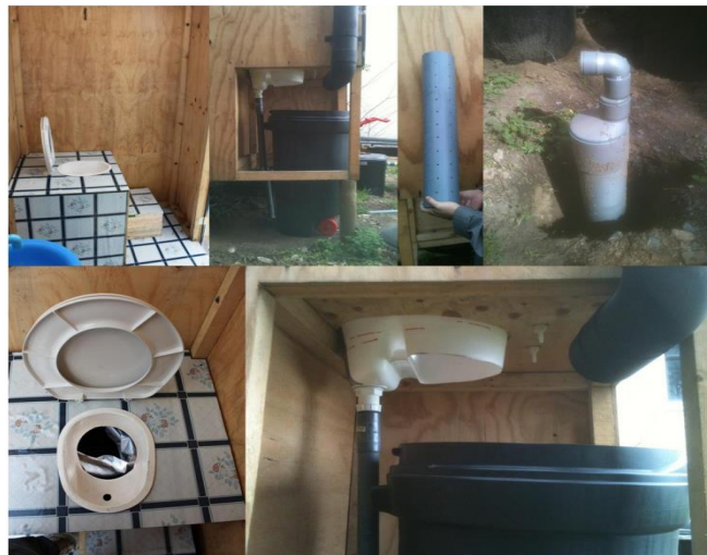
Figura 4: Baño BIS con separador de orina (Pizarro, 2012).
