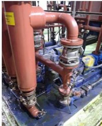
Fig. 62: Filtro de descarga bombas de baja presión del Molino SAG 1, Planta molienda SAG Los Bronces (fuente: creación propia)
