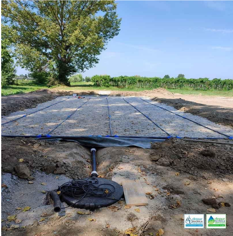
Figuras 3. Procesos instalación membrana. Depur técnica. 2025
