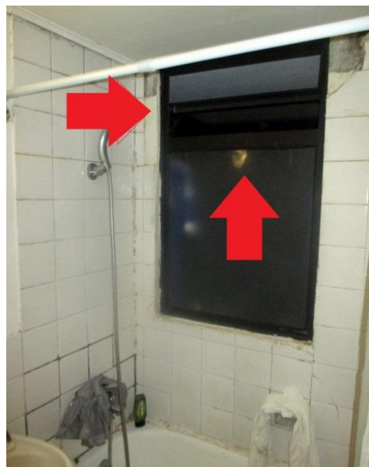
Imagen 3-2: Ventanilla ubicada en la tina del baño.
