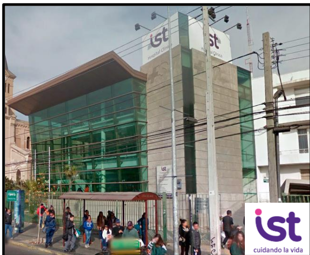
Imagen 3.5 Hospital Clínico IST Viña del Mar
