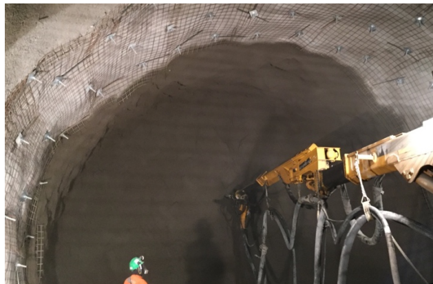
FIG.8: HRF PROYECTADO CON SISTEMA ROBOTIZADO
