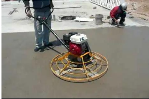
Figura 2-7. Trabajo de allanada tipo “helicóptero”
