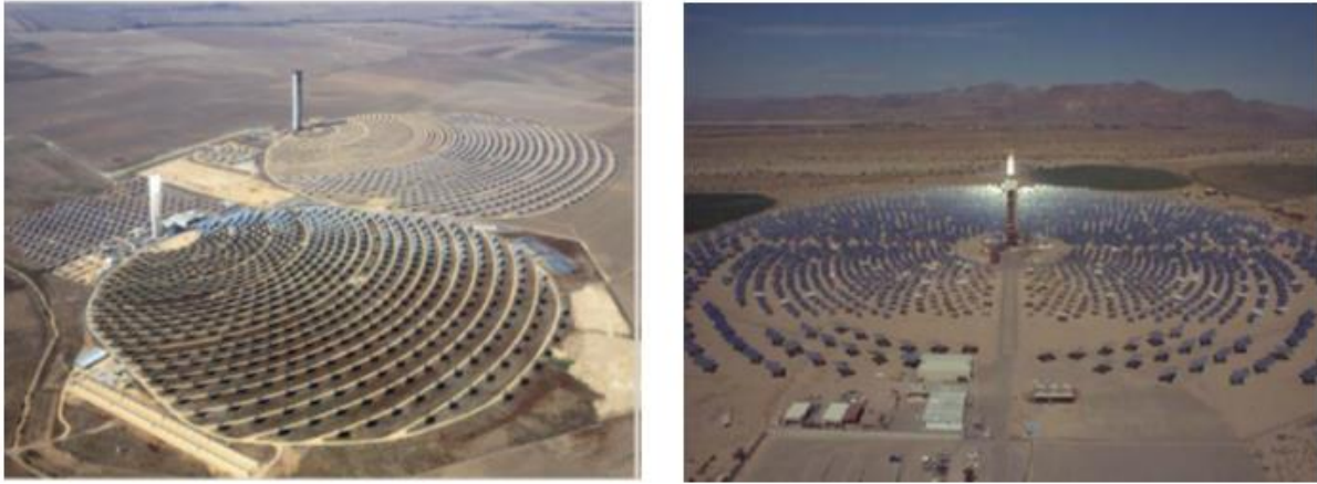
Figura 2.3: Configuración Norte/Sur a la izquierda (plantas PS10 y PS20 en Sanlúcar la Mayor Sevilla) y Configuración circular a la derecha (Solar Two Barstow, California). (4)
