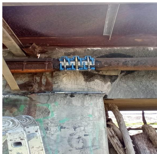
Figura: Reparación de filtración con collarín de reparación
