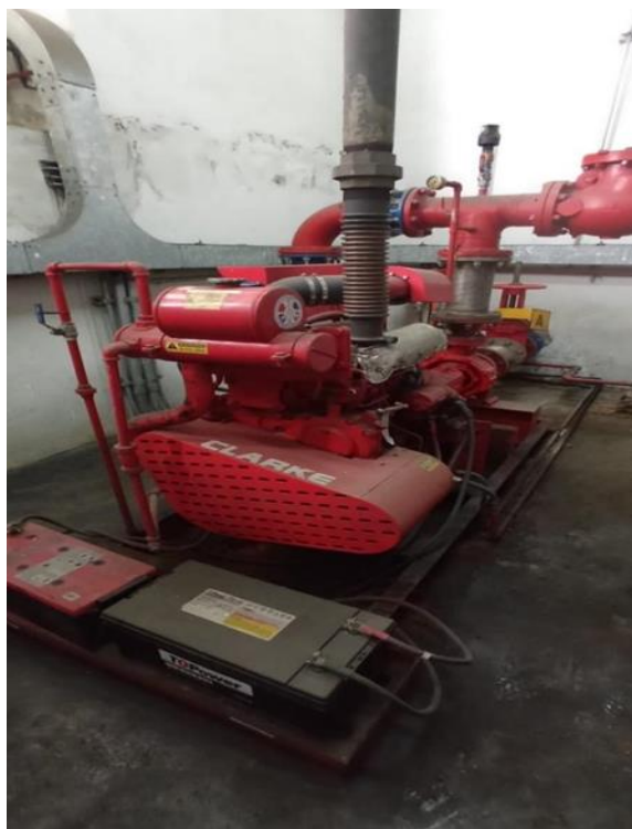
Figura: Conjunto Bomba – Motor
