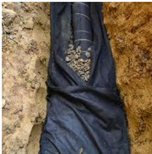
Figura: Geotextil en tubería
