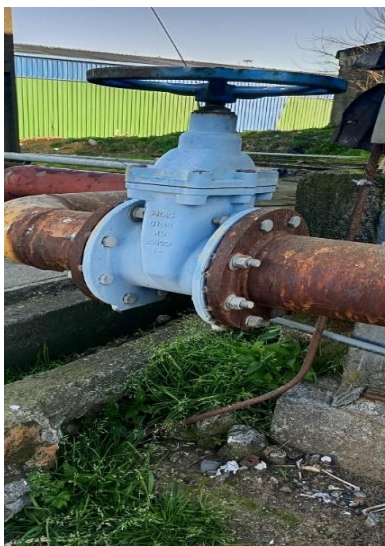
Figura: Válvula de compuerta Fuente: Propia
