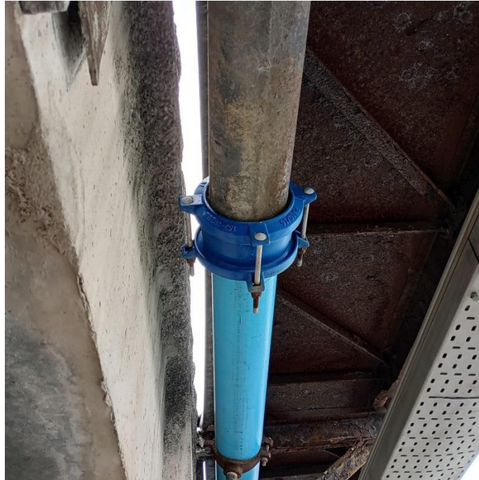
Figura: Segmento red de incendio “Embarcadero – Muelle 1”.
