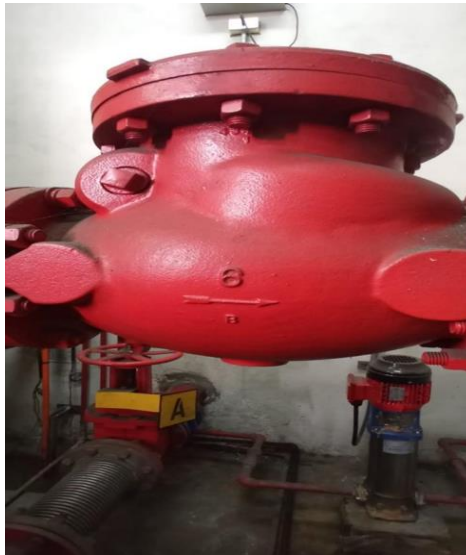
Figura: Válvula de retención Fuente: Propia
