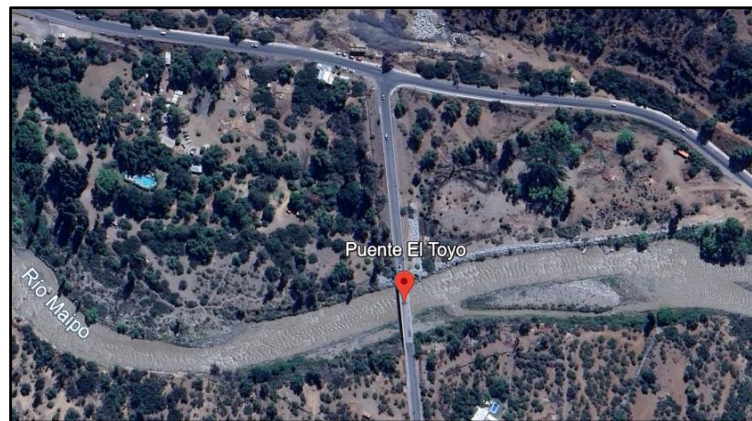
Fig 1. Ubicación general del puente El Toyo – Fuente Google Maps.
