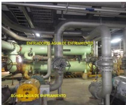
*Ilustración 19: Sistema agua enfriamiento*
