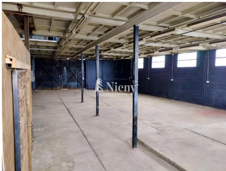
Figura 1.1 – Vista interior bodega opción 1
