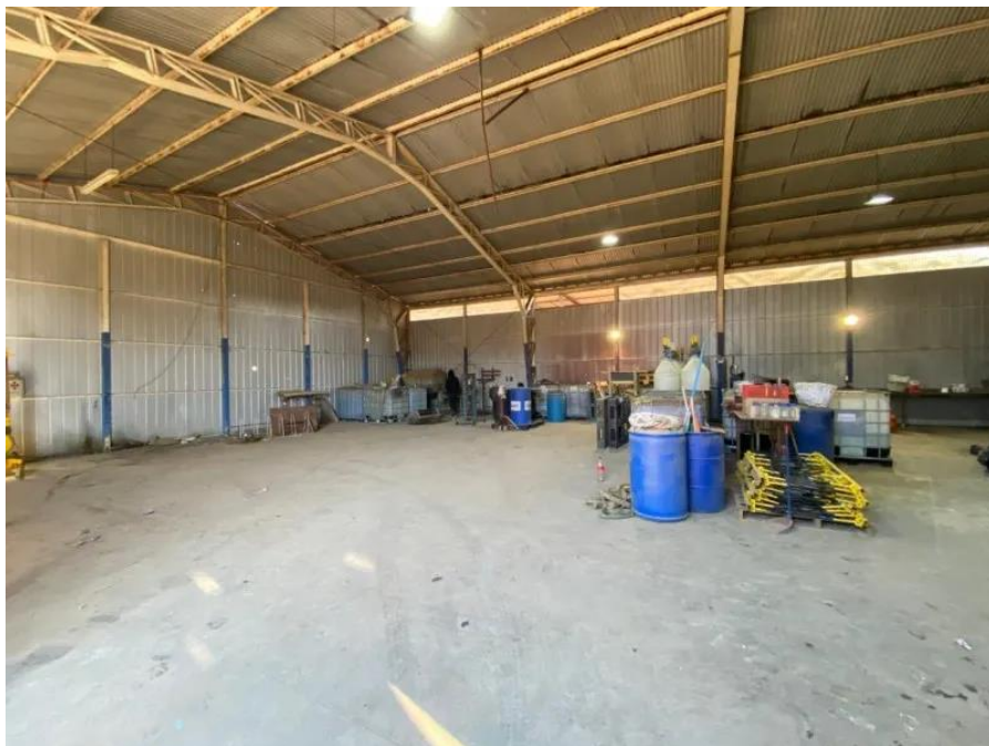
Figura 1.1 – Vista interior bodega opción 2
