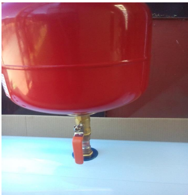
Figura 3. 20 Llave de seguridad vaso expansor tipo bola
