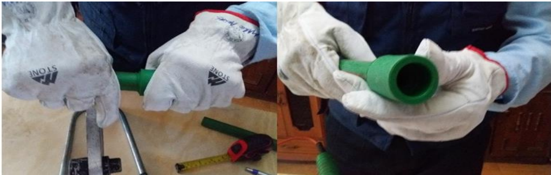
Figura 3. 13 Acople de piezas fusionadas
