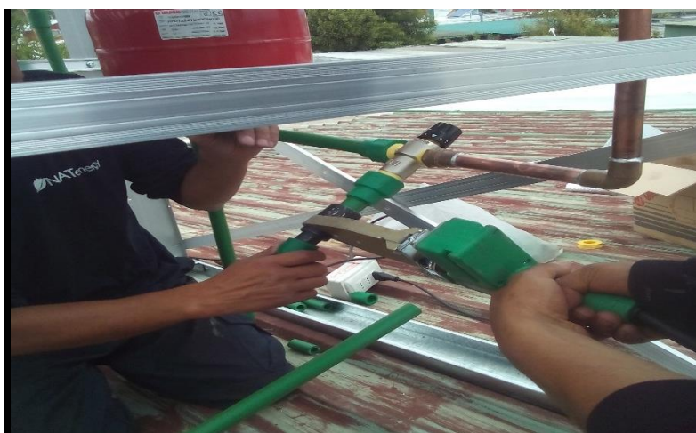
Figura 3. 23 Instalación válvula mezcladora parte inferior SST (no accesible)
