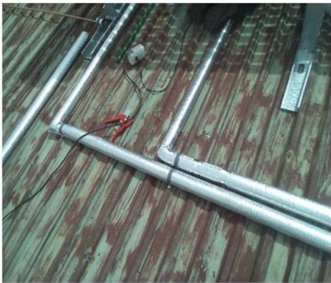
Figura 3. 9 Sistemas aislación térmica, revestimiento papel aluminio
