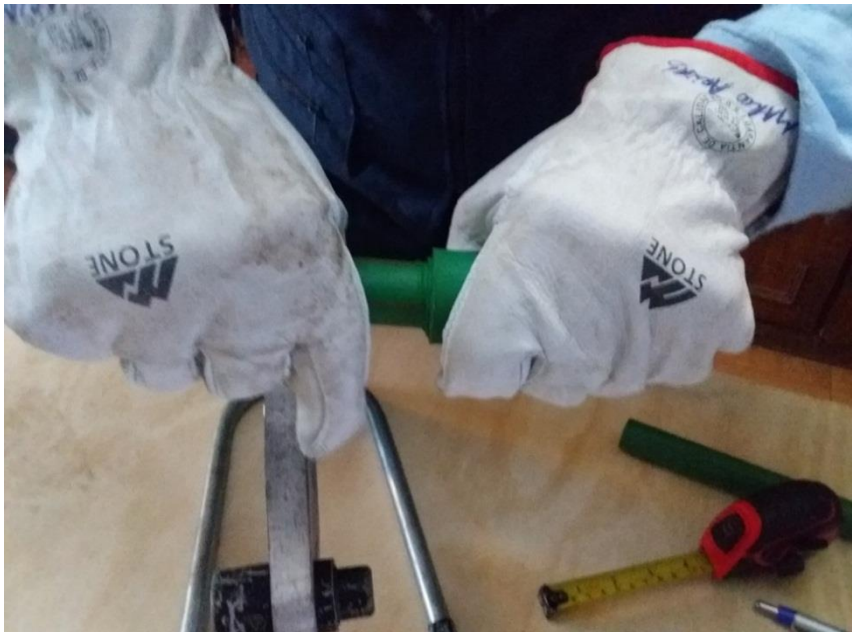
Figura 3. 14 No girar el tubo al conectarlo con la boquilla
