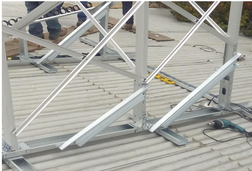
Figura 3. 6 Arriostramiento y refuerzos estructura SST
