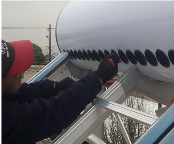
Figura 3. 30 Aplicación de pasta en la vaina de DA.
