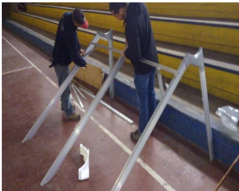
Figura 3. 4 Inicio de armado de estructura
