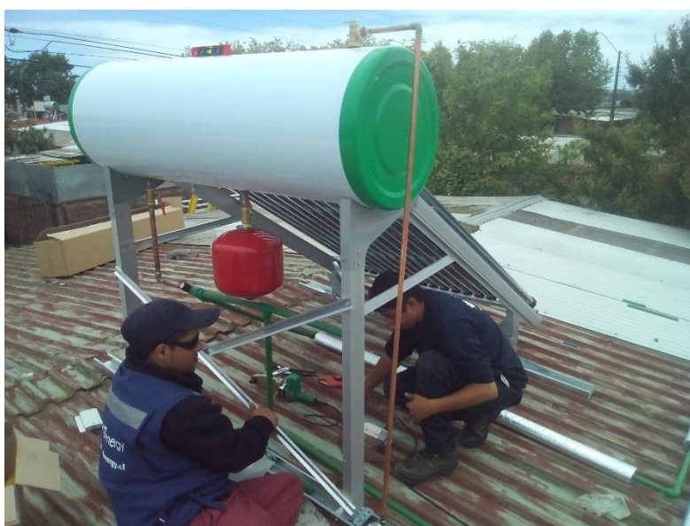
Figura 3. 32 Canalización válvula de alivio automática
