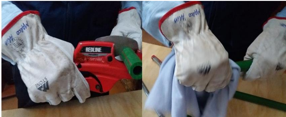
Figura 3. 10 Corte y limpieza de tubería PPR
