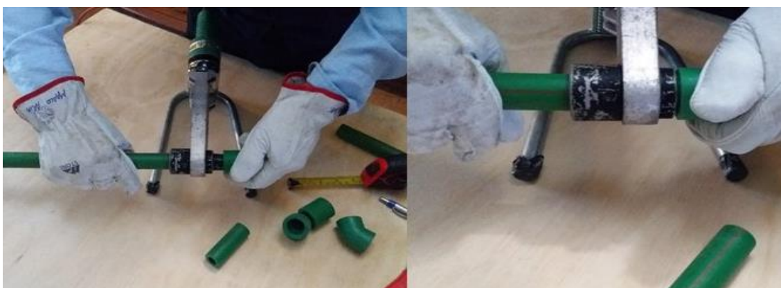
Figura 3. 12 Proceso de fusión de la pieza
