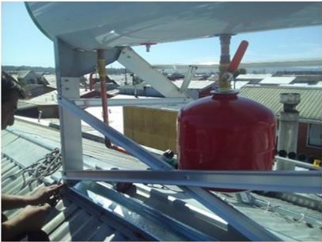
Figura 2.6 Estructura sobre caballete
