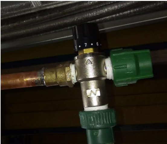
Figura 3. 21 Válvula mezcladora termostática válvula mezcladora. -
